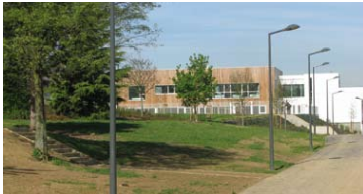
Ecole Vlamincck vue du parc - avril 2011
